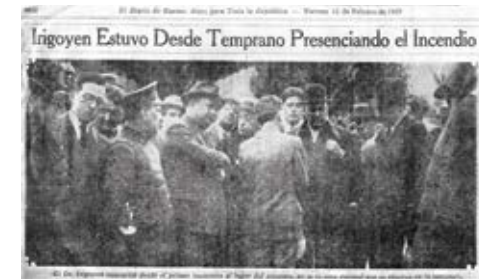
El presidente Irigoyen presencia el accionar de bomberos en el gran incendio de la Aduana, Crítica, 1929.
