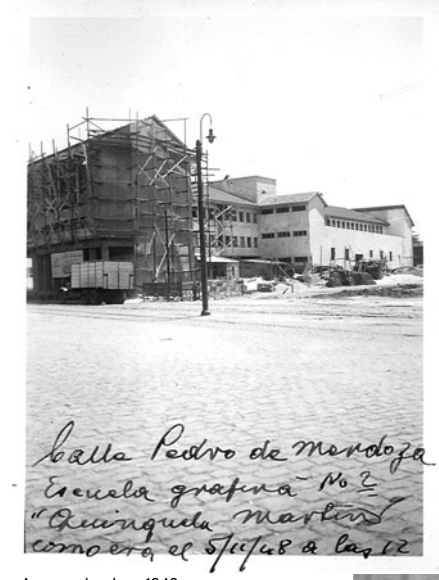
Avance de obra, 1948.
