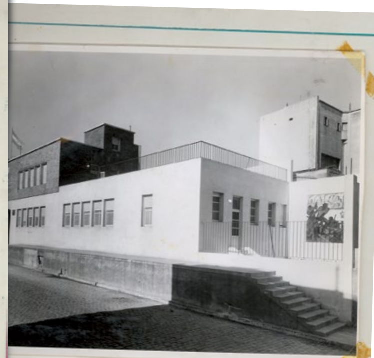
VISTA DEL SECTOR DEL LACTARIO N° 4, QUE DA SOBRE LA CALLE PALOS Y EN LA QUE SE OBSERVA EL MURAL EN ESMALTE SOBRE HIE- RRO FUNDIDO A 800°, ORIGINAL DEL PINTOR ARGENTINO BENITO QUINQUELA MARTIN.-
