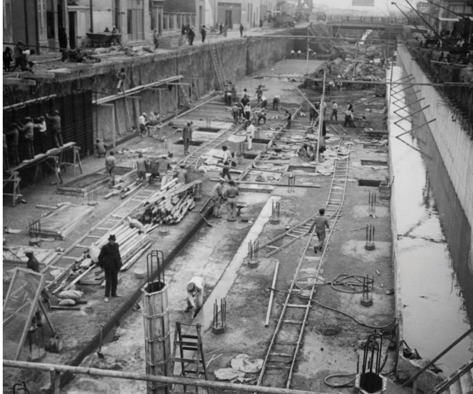
Tareas de entubamiento del Arroyo Maldonado. 1929. AGN
