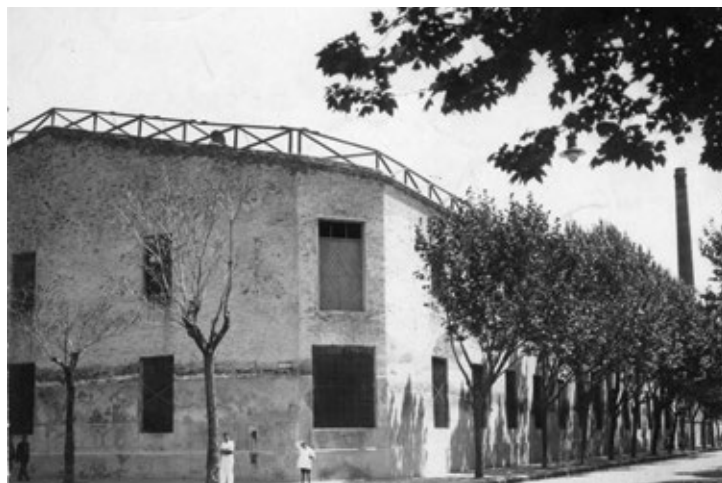
Edificio abandonado de la Curtiembre La Federal.
