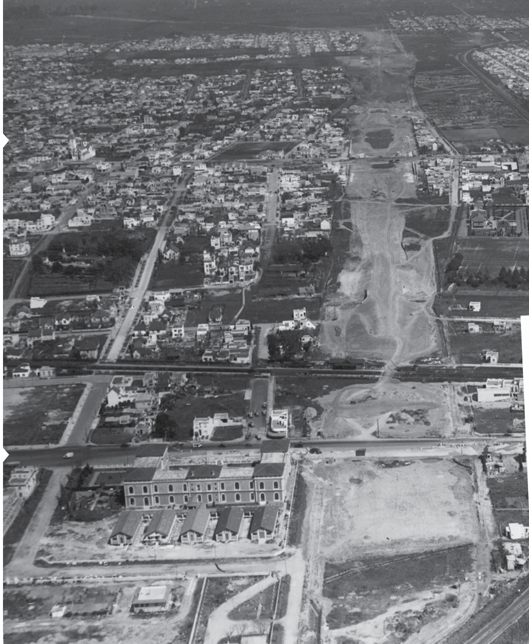
Vista aérea de la Av. General Paz en construcción. La primer avenida es la actual Libertador y arriba a la izquierda se ve San Isidro Labrador, 1938, AGN, INV 184731.
