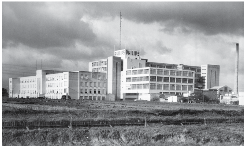
Vista del edificio de la fábrica Philips desde General Paz. AGN, INV. 237256.
