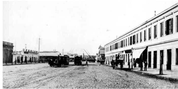
Av. Montes de Oca y Osvaldo Cruz. "Mercado del Banco Constructor".
