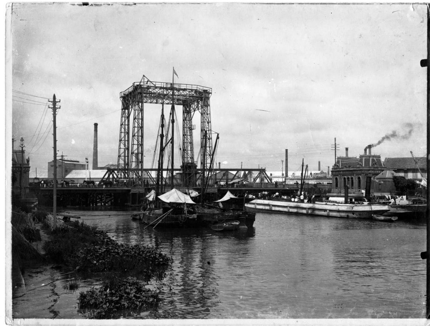
Puente de Barracas, metálico y con una sección levadiza, que comenzó a construirse en 1899 y librado al público el 31 de enero de 1903.
