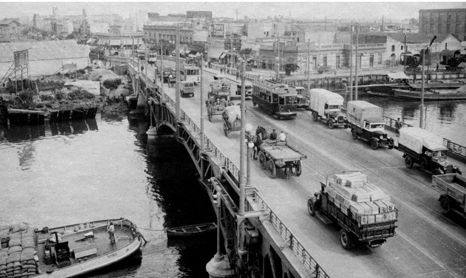
Puente sobre el Riachuelo. Diciembre de 1931.
