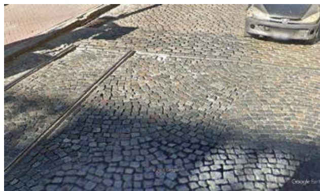
Figura 17. “Supervivientes” de diferentes patrones de adoquinado en un paño de adoquinado recientemente restaurado de la calle Defensa casi esquina Brasil
