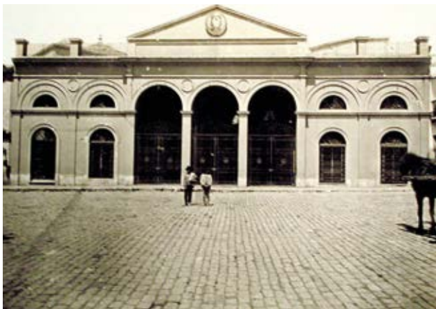
Figura 15. Frente del Congreso de la Nación en su antigua localización en Balcarce e Hipólito Irigoyen. Puede verse aquí un ejemplo del reemplazo de un sistema de empedrado por otro en el mismo sitio. Ambas fotos datadas alrededor del año 1864
