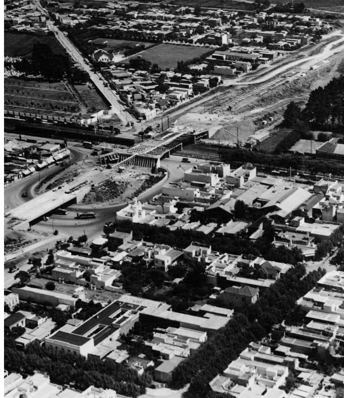
1940, Puente en obra sobre Av. Rivadavia (AGN)
