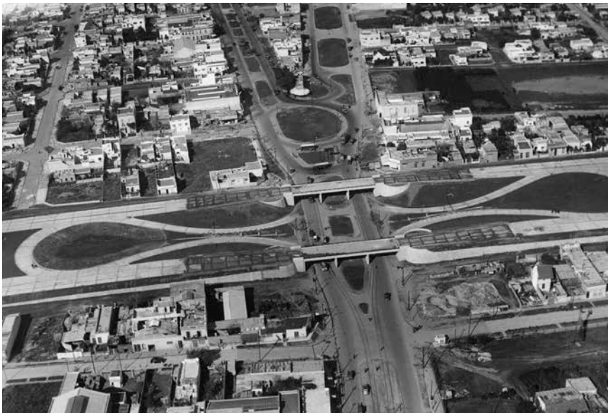
Avenida General Paz y Cabildo durante su construcción. Circa 1941. AGN
