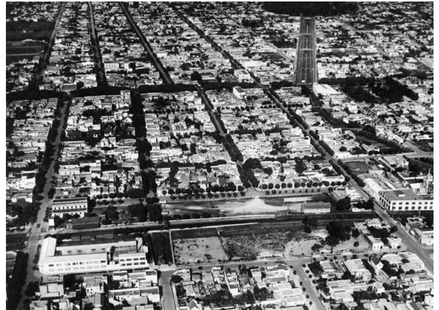
Vista aérea. Se observan, abajo, las vías del ferrocarril Mitre, entre Crisólogo Larralde y Campos Salles. Hacia arriba Cabildo, la plaza Florencia Balcarce, la avenida García del Río y el parque Saavedra. 1938. Archivo General de la Nación.
