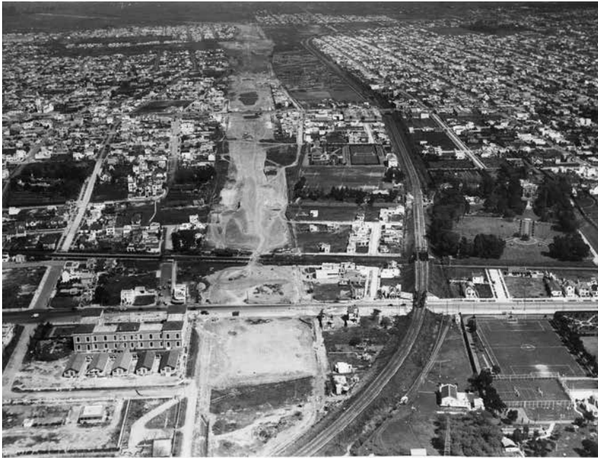
Avenida General Paz y Libertador durante su construcción, 1938. AGN
