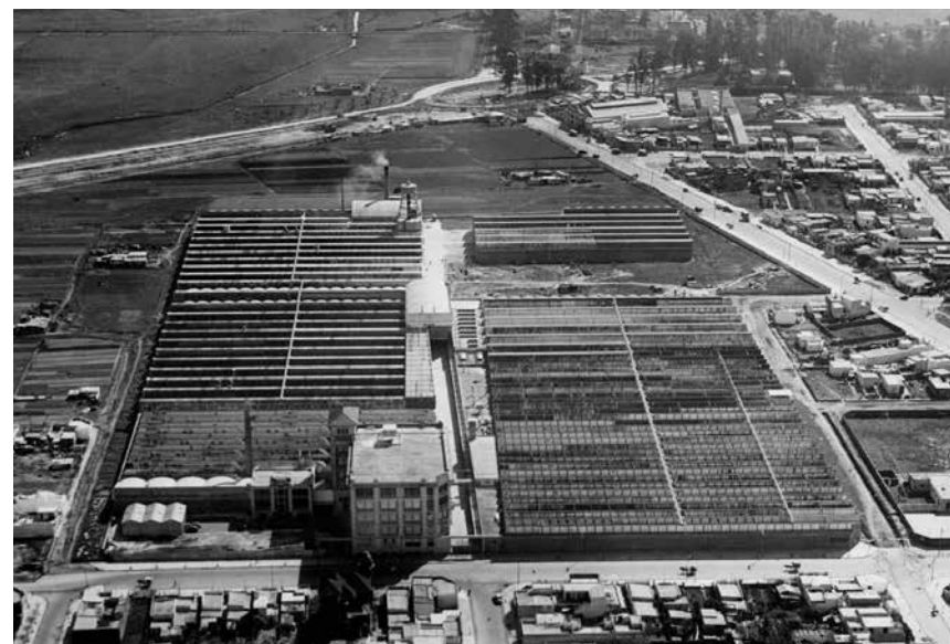
Fábrica GRAFA. Se observa el cruce de las avenidas Constituyentes y General Paz, la calle Medeyros y la arboleda de la chacra Saavedra. 1940. Archivo General de la Nación.
